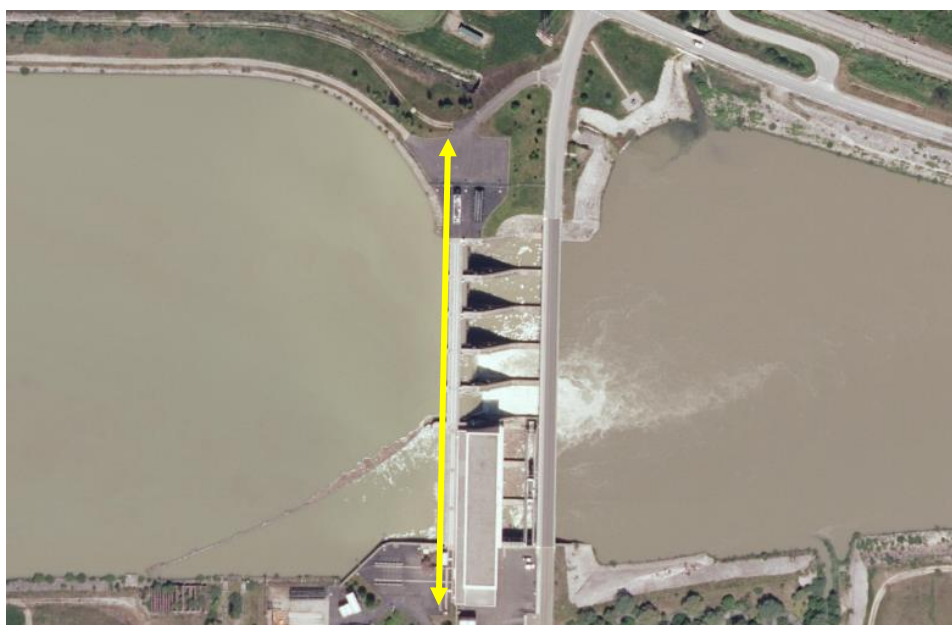
Slika: Primer zajema betonske pregrade za zadrževanje vode (podlaga DOF).
