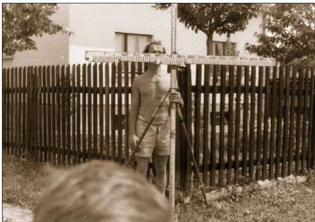
Slika 10.C.4: Primer tahimetrične meritve povečane natančnosti s horizontalno lato. Vir: Arhiv GURS
