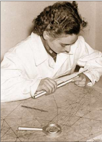
Slika 10.C.6: Pred aerosnemanjem se je v pisarni naredil točen načrt, po katerem je letalo slikalo teren. Kljub najsodobnejši tehniki tistega časa (aerosnemanje) pa se je za pripravo načrta še vedno uporabljalo logaritemsko računalno (nem. Rechenschieber).
