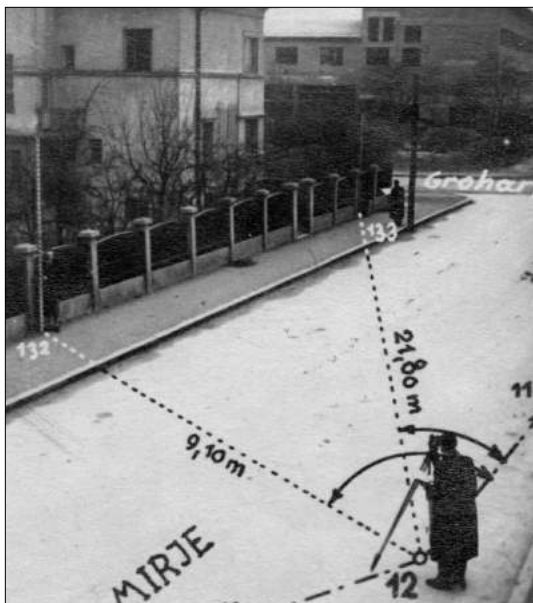
Slika 5.2.3.1: Prikaz načina polarne snemanja. Vir: Arhiv GURS
